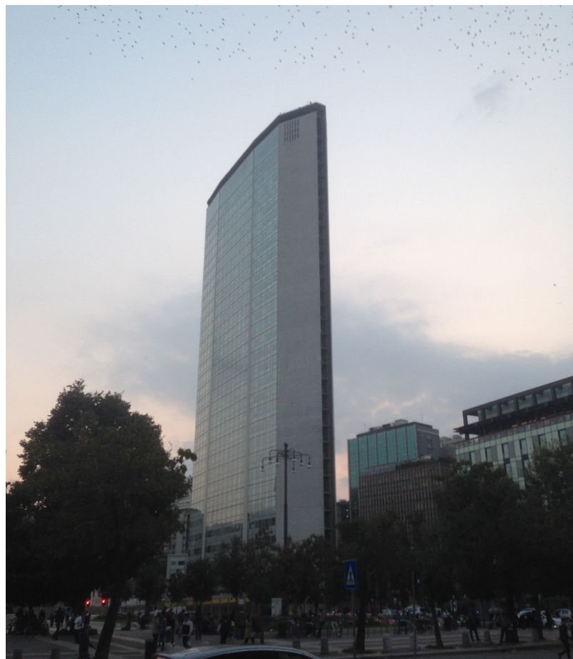
Figura 11 Milão, Arranha-céus Pirelli, arquiteto Giò Ponti, situação depois da restauração. Fotografia: Nivaldo Vieira de Andrade Junior
