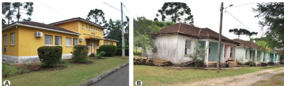
Figura 11 – Edificações do antigo Leprosário São Roque utilizadas atualmente pelo CPPI, em 2018.
