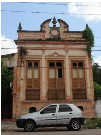
Figura 5 e 6 – Tipologias de edifícios localizados na Rua Siqueira Mendes e Avenida Lopo de Castro, respectivamente, no bairro do Cruzeiro. Fonte: Acervo Pessoal (2017). Colaboração: Leilane Dias.
