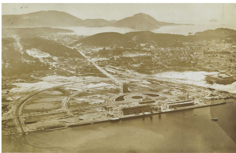
Figura 4 Imagem do aterro de São Lourenço em construção, 1930. Fonte: Acervo Digital da Biblioteca Nacional.
