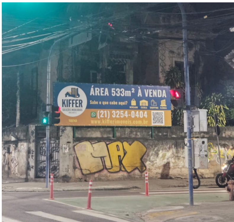
Figura 13 Edificação do século XX em estado de ruína após abandono e incêndio. Fonte: Acervo autoral.
