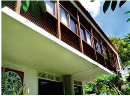
Res. Austregésilo de Freitas (1958?) Arq. Acácio Gil Borsoi.
