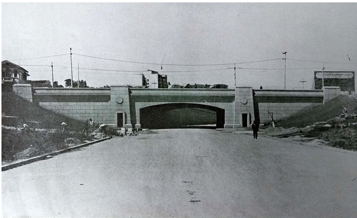
VIADUTO PACAEMBÚ, no cruzamento das avenidas São João e Pacaembú
