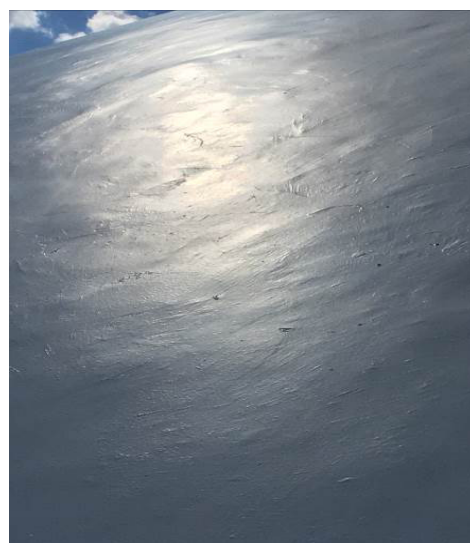
Figuras 12 e 13: Edifício Principal. Cúpula do Senado. Aspecto após pintura; Superfície irregular e com brilho excessivo. Fonte: Senado Federal / Sinfra (2023).
