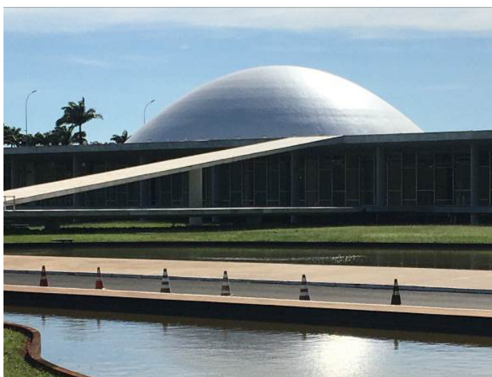
Figuras 12 e 13: Edifício Principal. Cúpula do Senado. Aspecto após pintura; Superfície irregular e com brilho excessivo. Fonte: Senado Federal / Sinfra (2023).
