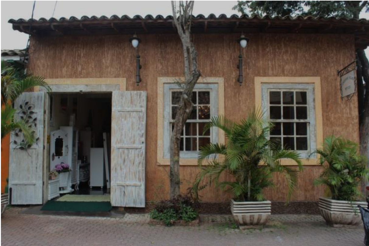
Figura 4 Após a demolição de um exemplar do século XIX, um exemplo da reconstrução em “estilo colonial”. Fonte: Arena, 2013. (publicação autorizada pela autora)
