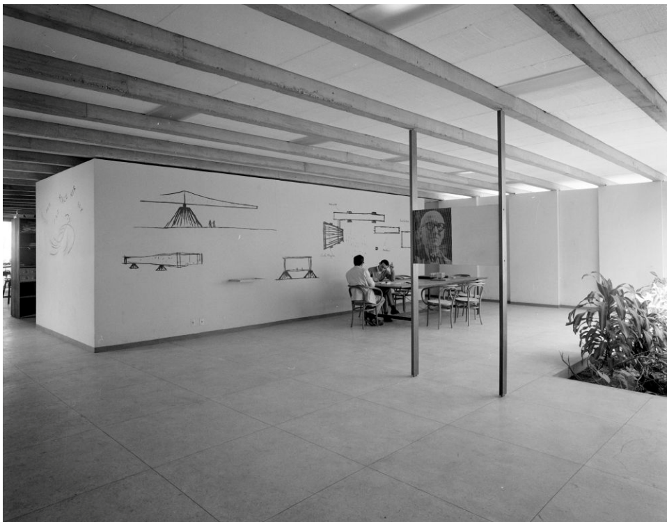
Figura 2 – interiores do CEPLAN, com as vigas protendidas e os painéis portantes ao fundo. Fonte: IMS
