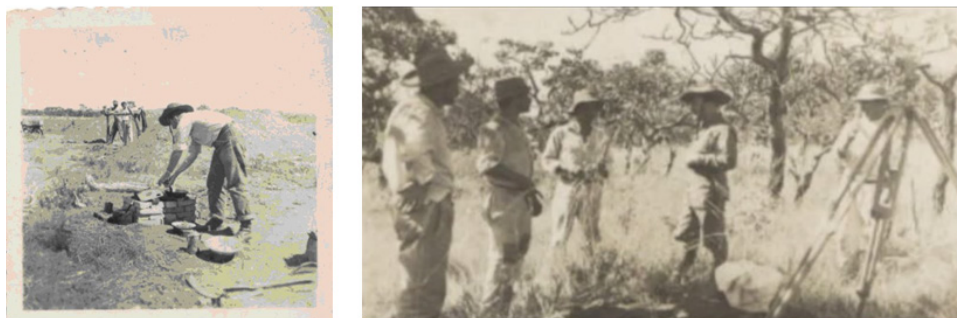
Figura 5 – a) Colocação da pedra fundamental do município, em 1957, próximo à rodovia Brasília-Anápolis; b) Demarcação de vias da nova trama urbana no cerrado, em 1957. Fonte: Alex Abdallah, 2012.
