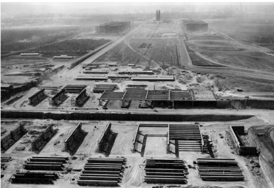
Figura 1 – construção pré-moldada da Plataforma Rodoviária em primeiro plano, com as obras em aço dos Ministérios ao fundo. Fonte: ArPDF
