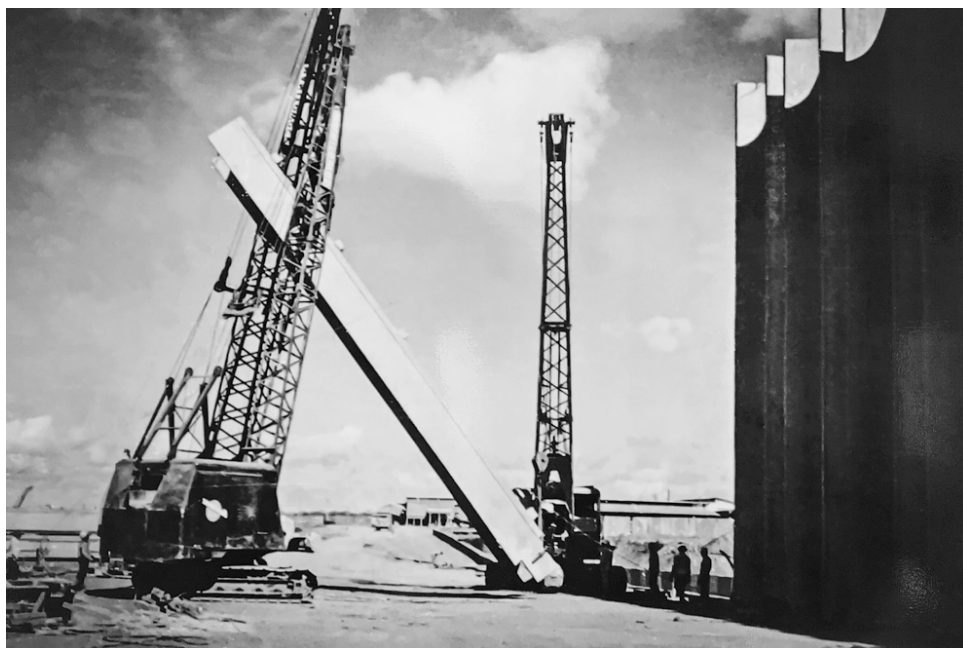
Figura 13 – foto da construção do Bloco 1 do Quartel-General do Exército. Fonte: acervo do QGEx.
