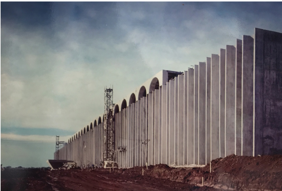
Figura 12 – foto da construção do Bloco 1 do Quartel-General do Exército. Fonte: acervo do QGEx.
