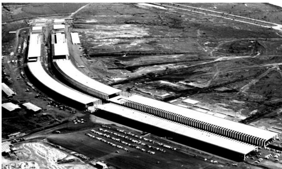
Figura 4 – Foto aérea do ICC e do campus em construção. Fonte: UnB Agência – www.unb.br .
