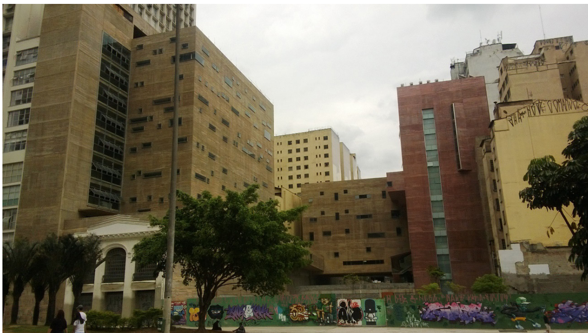
Figura 01 Praça das Artes - Vista da Rua Formosa Fonte: Masao Kamita
