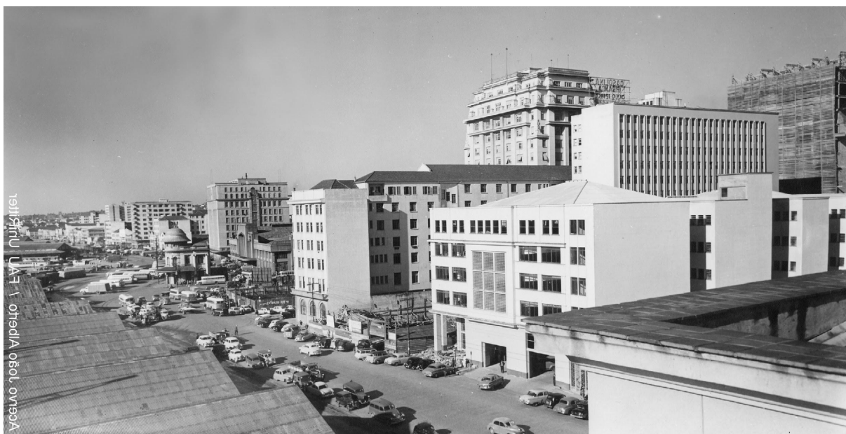
Figura 04 Fotografia da cena do terreno onde seria construído o Edifício Formac Fonte: Acervo João Alberto Fonseca da Silva/UniRitter
