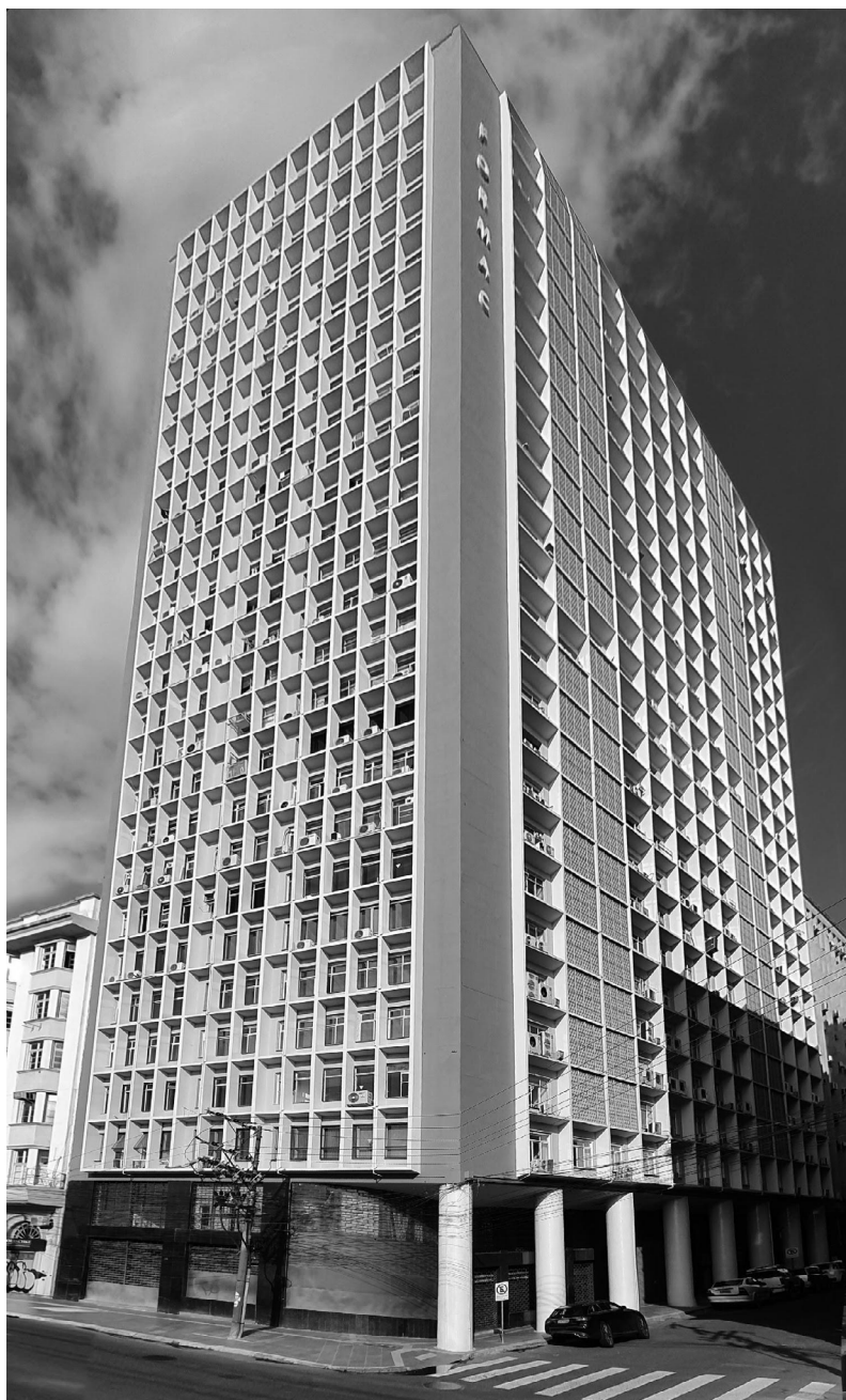
Figura 03 Situação atual do Edifício Formac Fonte: Autores
